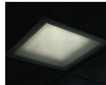
Iluminación LED autoregulada
